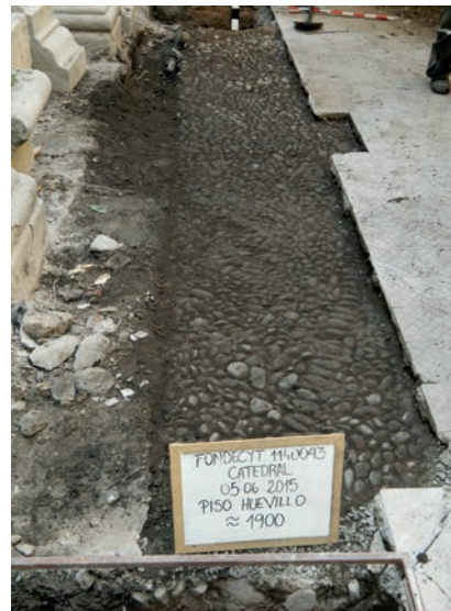
FIGURA 7. Piso de huevillos bajo el piso de baldosa actual, de inicios del siglo XX o previo
