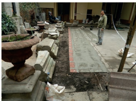
FIGURA 9. Restitución de las baldosas del Patio los Naranjos
