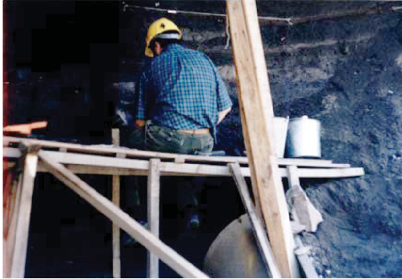
FIGURA 88. Andamio preparado para la excavación.
