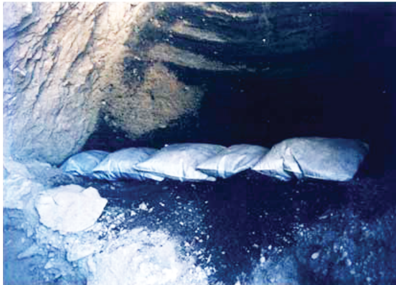
FIGURA 91. Sacos apilables de geotextil con sedimentos del sitio
