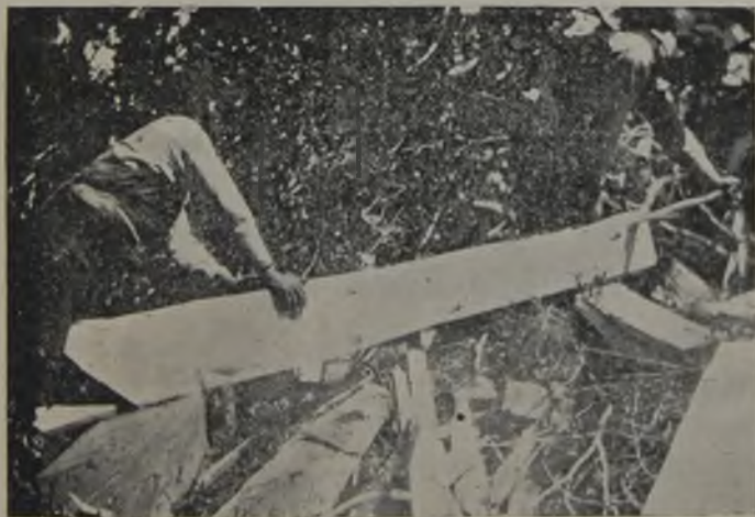
FIG. 49.—Partiendo tablas de los cuartones de alerce
